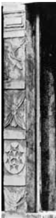
45 Roma, S. Lorenzo f. l. m.: pilastro della recinzi- one, con riquadri
